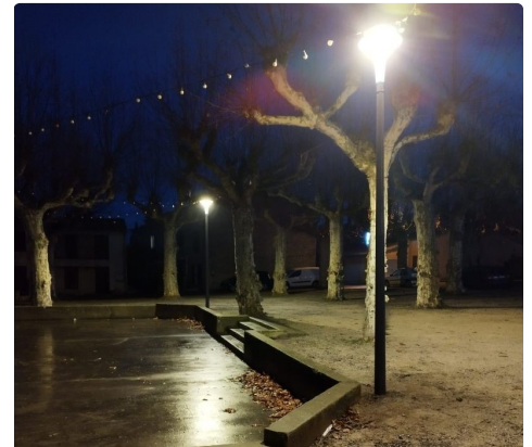
Enfouissement éclairage public
